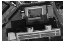
小学校のプール
